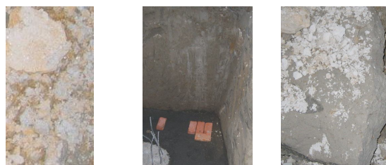
(a) 处理前土样 (b) 处理后电梯井 (c) 开挖土块
